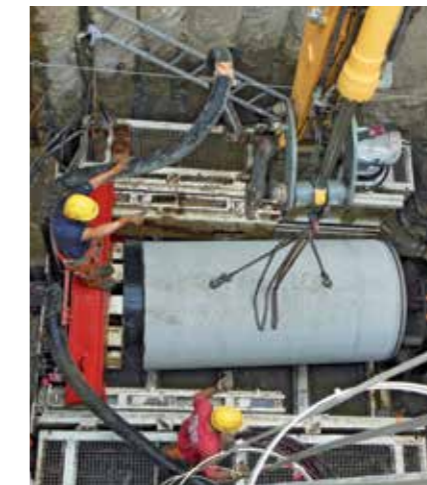
Déplacement du poste de refoulement des eaux usées de Saint-Romain-en-Gier © SYSEG
