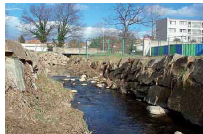
L'Egotay à l'aval du pont de la rue de l'Industrie à Unieux avant et après aménagement du lit et des berges
