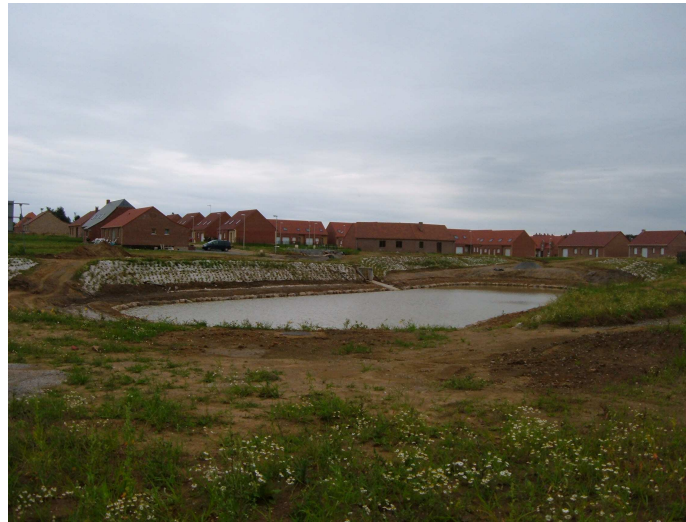
Photographie n°9 : Un bassin collecteur des eaux pluviales (Cliché : S. Azambre, 2008)
