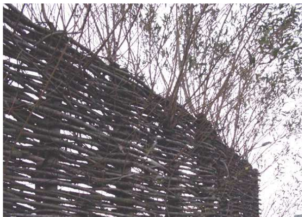
Photographie n°5 : Clôture en osier vivant (Cliché : comm. pers. F. Lamiot, 2008)
