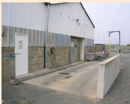
La table de préparation est pratique et permet de limiter les mauvaises manipulations de bidons. Quant au stockage phytosanitaire, bien que réglementaire, il permet d'assurer la sécurité, de mieux gérer les stocks, mais également de limiter les risques de dispersion de produits dans le milieu.
