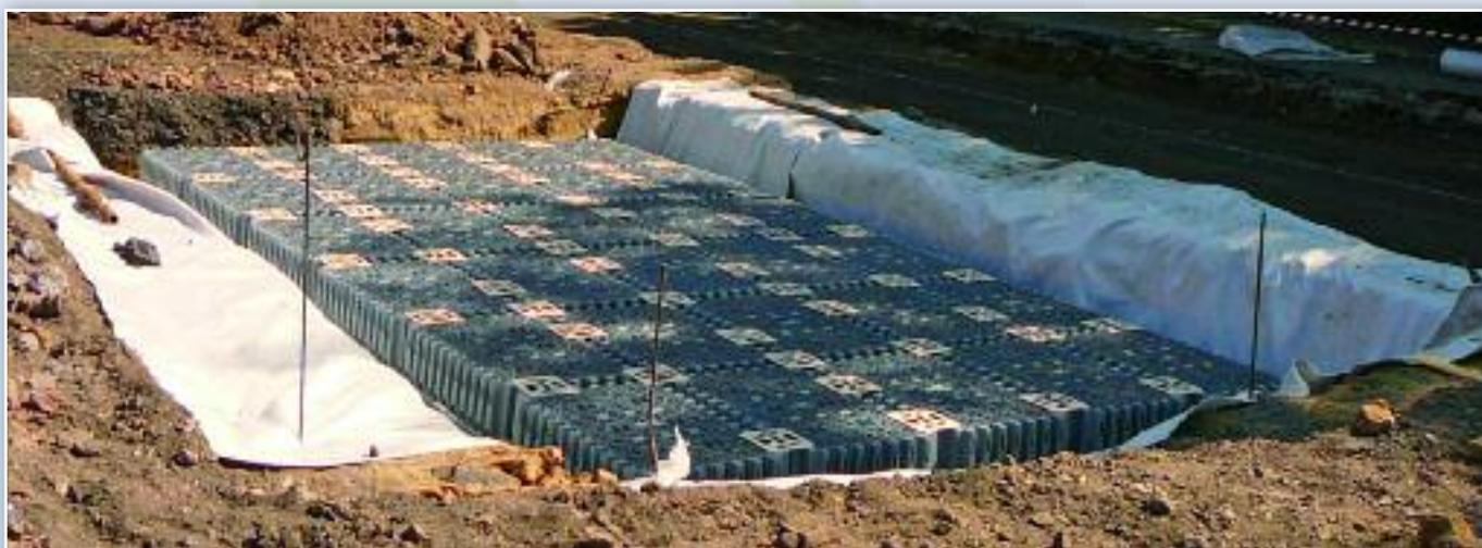
La structure réservoir avec matériaux synthétiques trouve facilement sa place sous une chaussée. Une fois recouverte, elle est totalement invisible.
