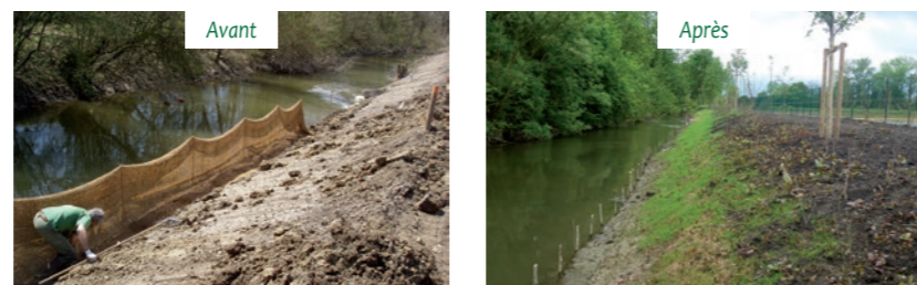
Réalisation de travaux en bordure de berges, Cessieu
