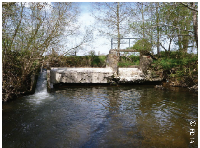
Ouvrage abandonné sur l'Odon
