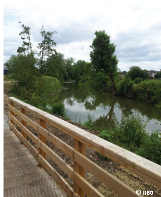
© IIBO Passerelle en bordure de l'Orne au Clos Menou
