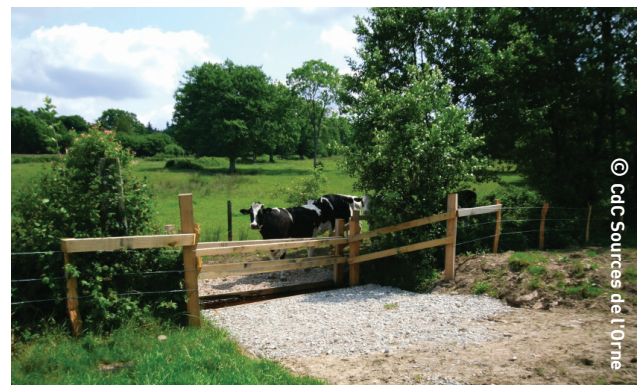
Gué réaménagé avec pose de clôture
