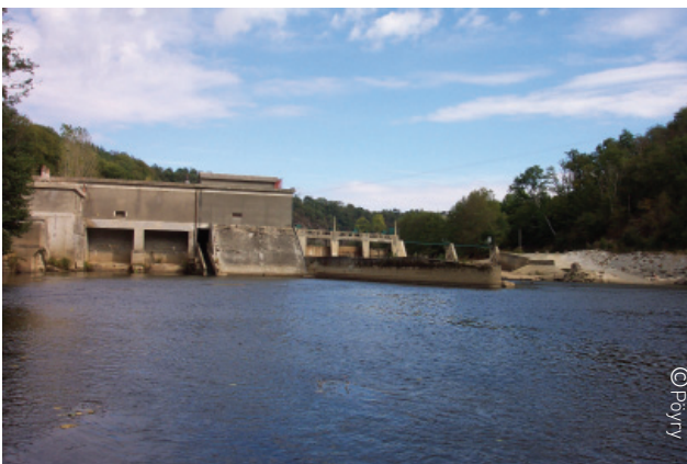
Barrage de La Courbe, barrage fonctionnel
