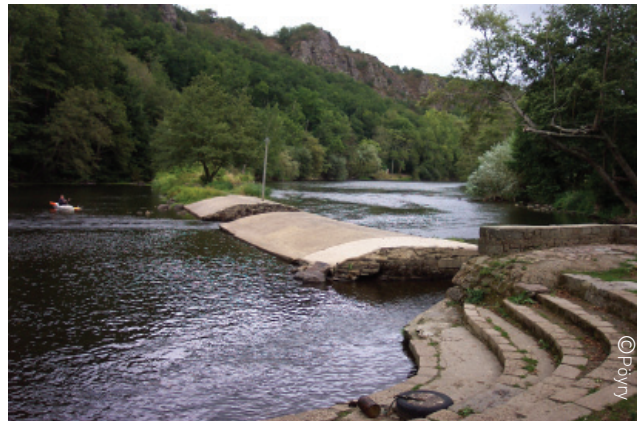
Brèche au barrage de la Faverie
