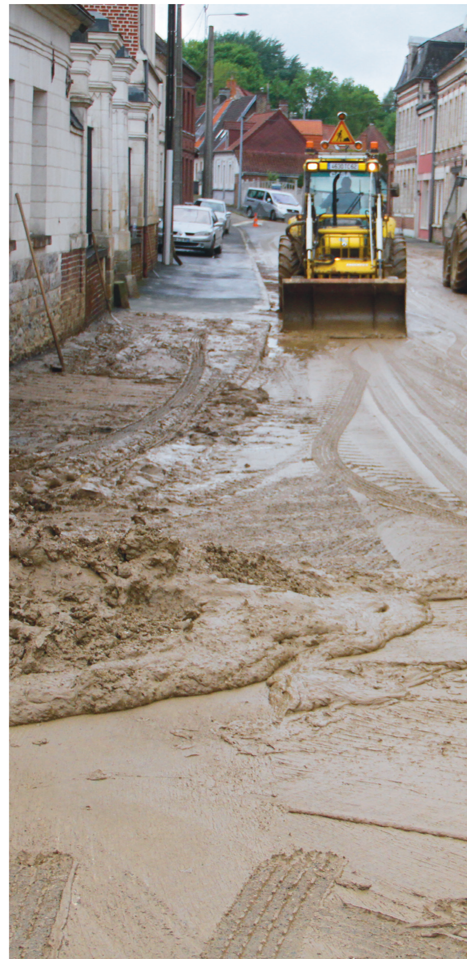
Les coulées de boue (ici à Aubigny-en-Artois) peuvent provoquer des dégâts considérables sur les voiries et habitations © Mairie d'Aubigny-en-Artois
