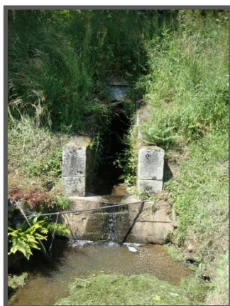
Seuil à Saint Jouan de l'Isle bloquant la continuité écologique du cours d'eau
