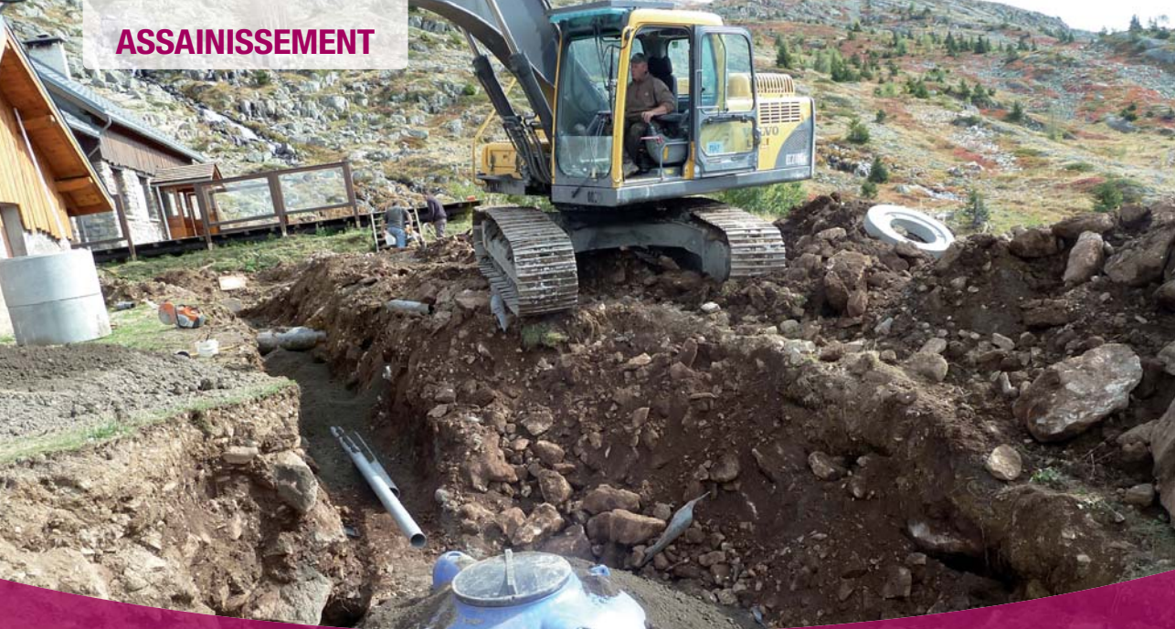
^ Travaux d'assainissement au restaurant d'altitude « Chez Passoud », à Oz-en-Oisans
