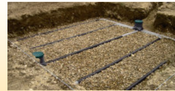
Lit filtrant vertical non drainé
