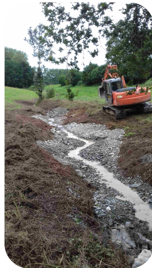
Réhaussement de lit de cours d'eau à Cogles réalisé par le syndicat Mixte du Couesnon Aval
