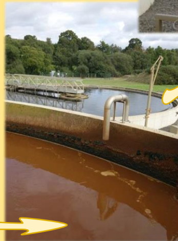
Traitement biologique par boues activées puis décantation finale dans un bassin de clarification pour séparer l'eau et les boues ; boues qui seront principalement valorisées en méthanisation à l'usine Géotexia de St-Gilles du Mené.
