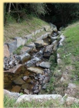
Travaux de restauration morphologique sur la Rance
