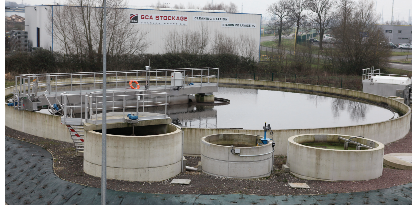
Nouvelle station d'épuration de Lillebonne
