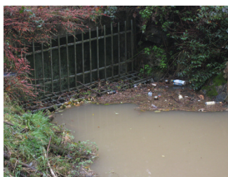
La grille de la piscine de Bolbec est bouchée régulièrement par les végétaux et les déchets (bouteilles).
