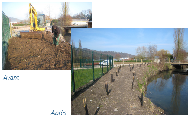
Chantier de l'ancienne station d'épuration de Lillebonne
