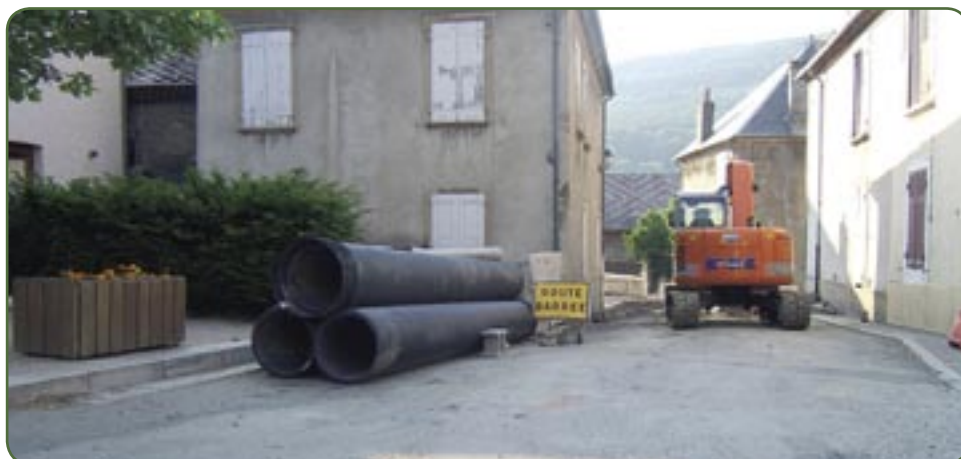
« A Notre-Dame de Vaulx, les travaux de réalisation des réseaux séparatifs sont en cours »
