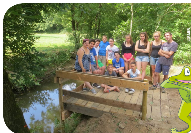
Ponton réalisé par le chantier jeunes
