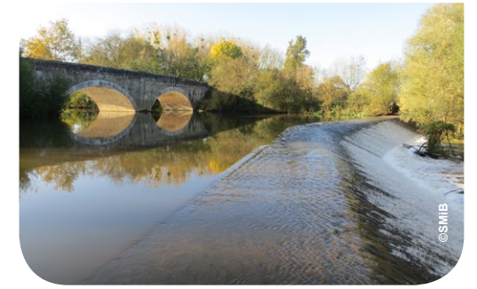
Chaussée du Marillais
