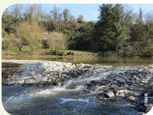
Aménagement d'une passe rustique
