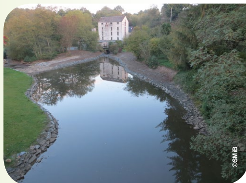
Aménagement de banquettes
