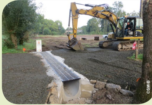
Ouvrage de franchissement
