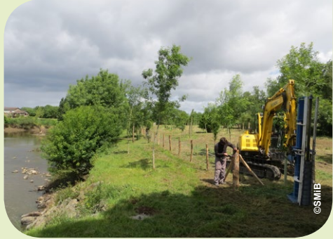
Pose d'une clôture
