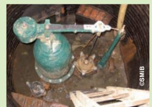
Mécanisme du béliet hydraulique
