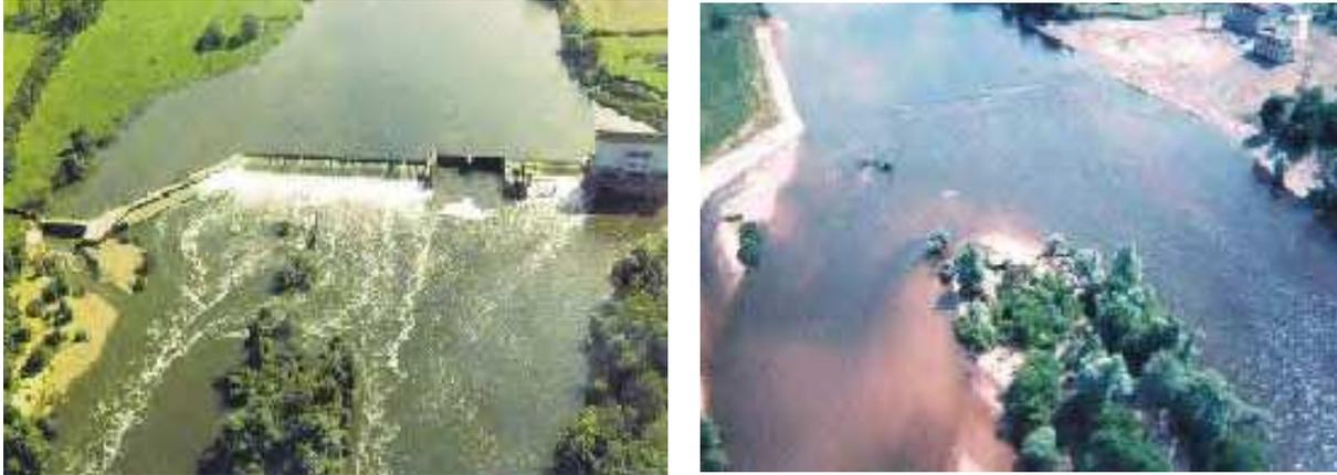
Figure 14 : Photos avant et après la suppression du barrage Maisons-Rouges. Source : DIREN Centre
