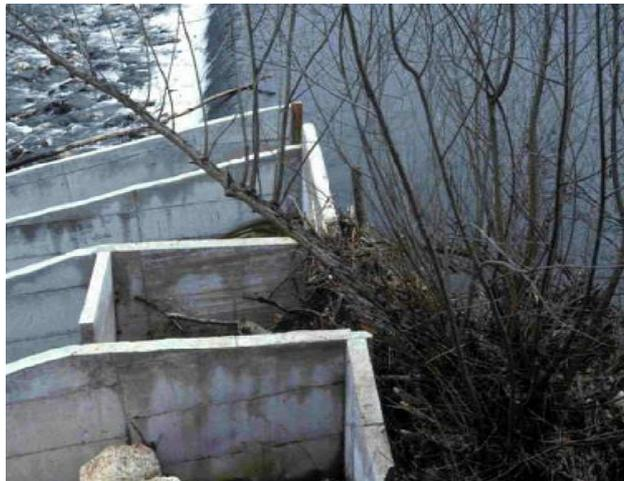
**Figure 21 : Embâcle supprimant l'efficacité du dispositif de franchissement. Source : ONEMA**
