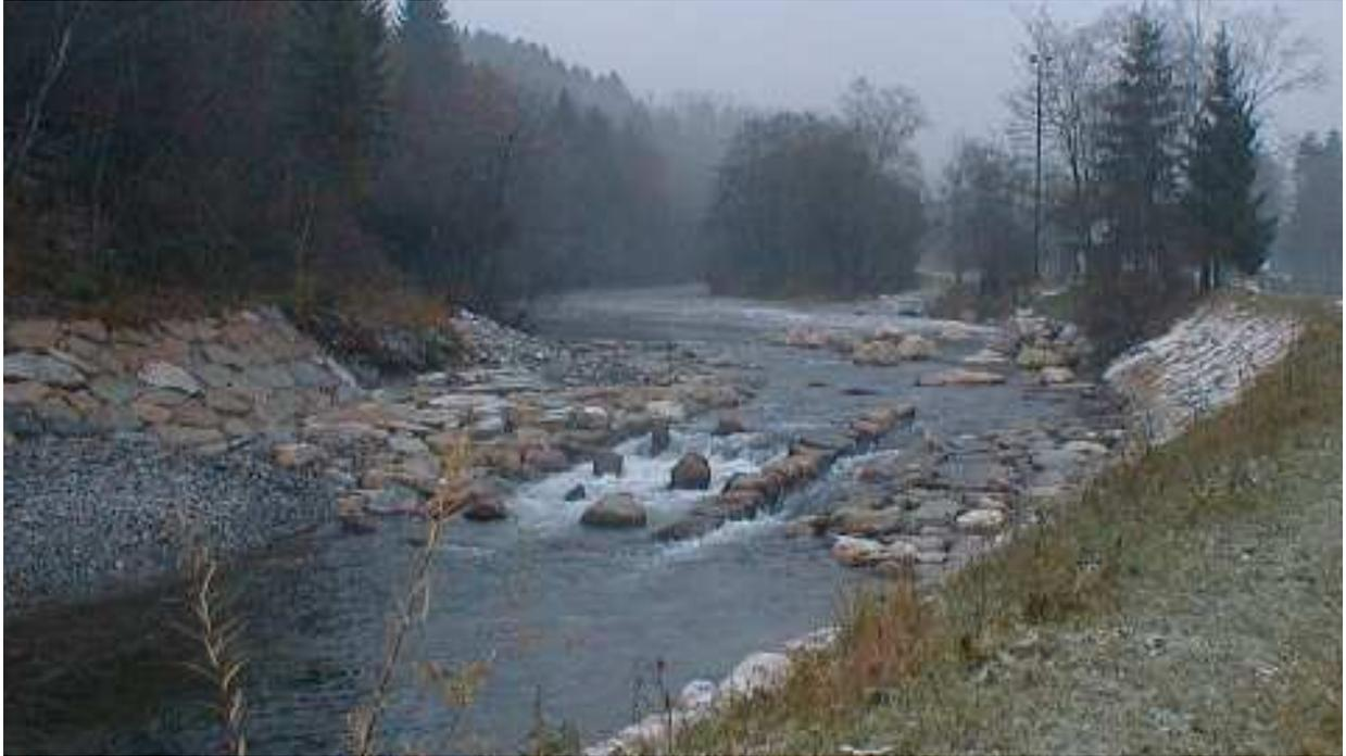
Figure 20 : Seuil équipé de passes à canoës et à poissons à La Motte en Bauges. Source : SMIAC
