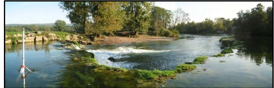
PHOTO 1 : BARRAGE DE LOMBARD, SITE D'IMPLANTATION D'UNE FUTURE PASSE A POISSONS
