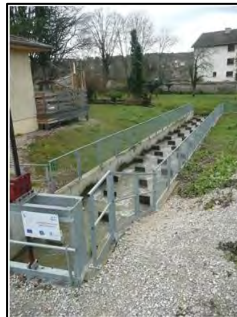
PHOTOS 2 : PROJET DE PASSE A POISSONS SUR LE BARRAGE GERVAIS (DOSSIER EN COURS AU STADE D'AVANT PROJET)
