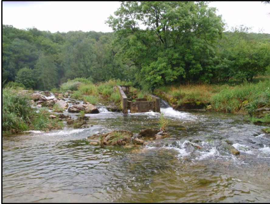
PHOTO 4 : PASSE A POISSON DU BARRAGE DES FORGES A BUILLON.
