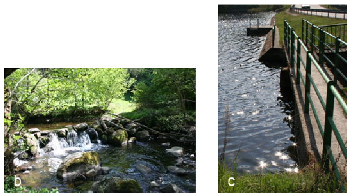
Figure 30: Photographies du seuil de Grandet (b) et du plan d'eau de la Tour (c)
