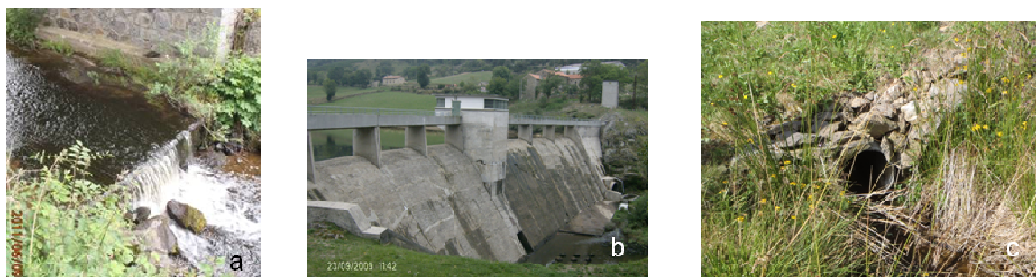
Figure 17: Photographies d'un radier (a), d'un barrage (b) et d'une buse (c)
