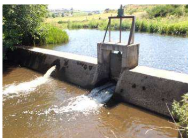
Figure 18: Photographie d'un ouvrage mobile présent sur la Seuge
