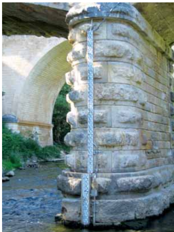
Échelle limnimétrique sur l'Arc à Roquefavour
