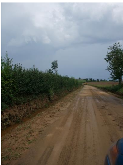
Figure 21 : Coulée boueuse sur la route du May à Jallais
