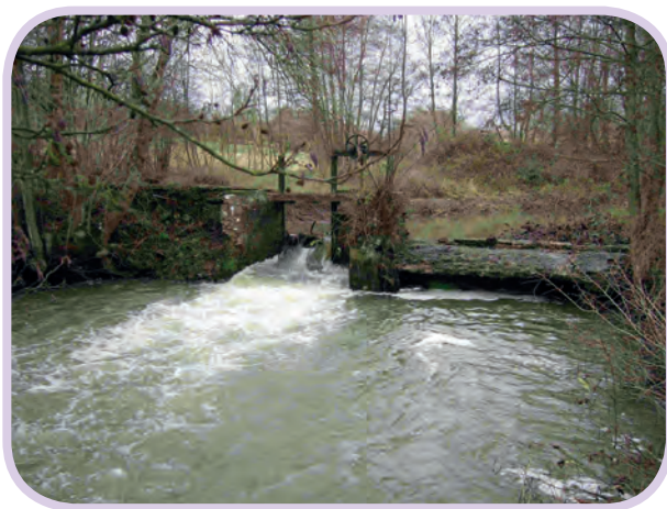
Ouvrage sur la Risle Ornaise avant travaux
