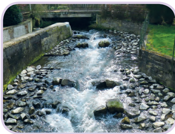
Rétablissement de la continuité sur le moulin Rica
