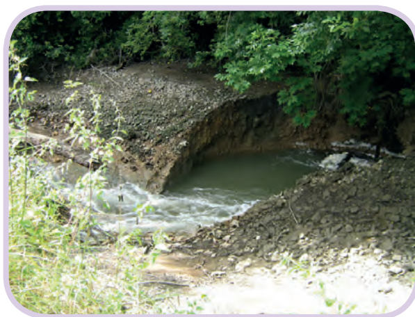
Ouverture de bétoire dans le lit mineur de la Risle en juillet 2012 en limite de communes entre Ajou et La Houssaye
