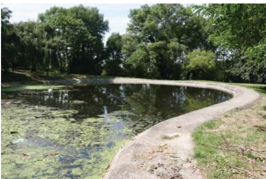
Figure 77 : Bassin de la Butte Pinson
