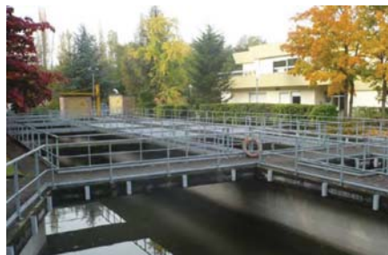
Figure 24 : CTR - vue sur les chambres à sable
