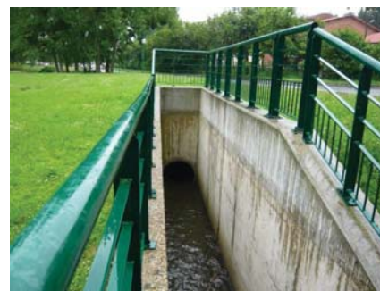
Figure 33 : Ezanville : le Petit Rosne enterré en souterrain
