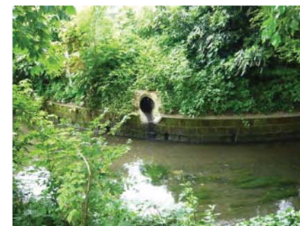
Figure 34 : Gonesse : les berges maçonnées du Croult
