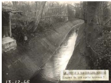
« Aspect du lit après travaux » (13 décembre 1946)
