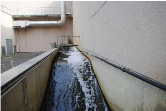
Canal de comptage des eaux épurées (SIAH)
