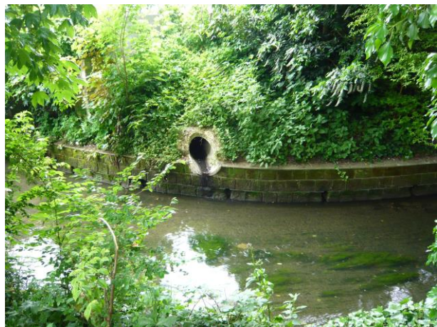
Figure 23 : exutoire pluvial dans le Croult à Gonesse
