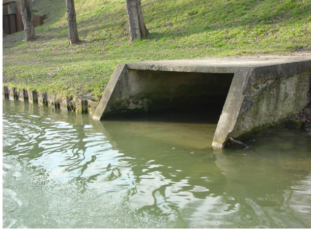
Figure 21 : exutoire pluvial dans le canal de l'Ourcq, au niveau du Pont de Mitry à Tremblay-en-France (source : DEA93)
