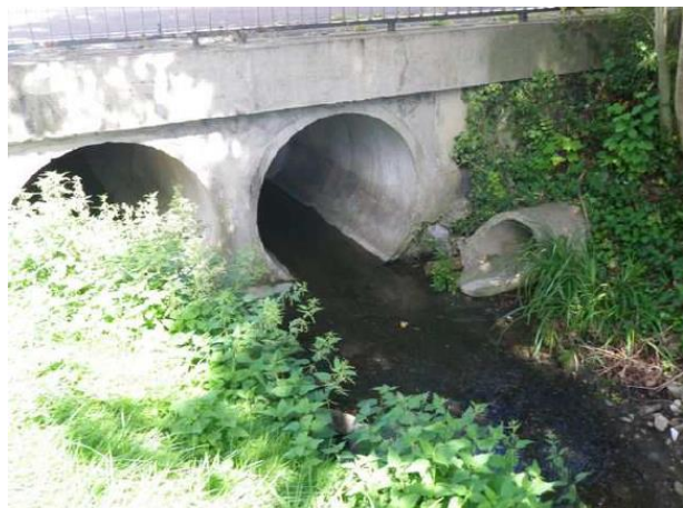
Figure 20 : exutoire pluvial dans le ru de Montlignon / voie de la Rocade à Montlignon (source : SIARE)
