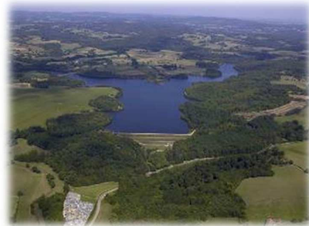
Barrage de Miallet sur la Dronne
