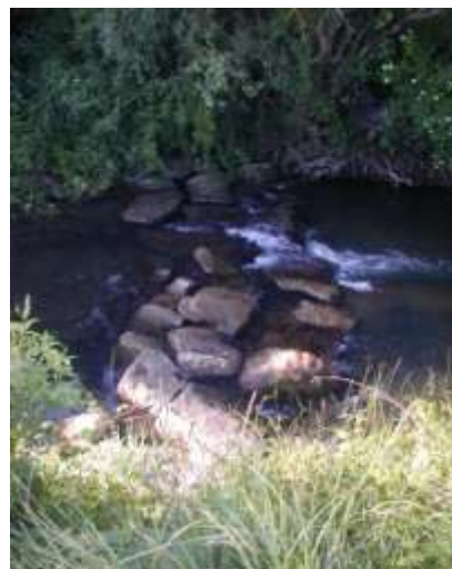
Figure 12 : Seuil par la pose de blocs
