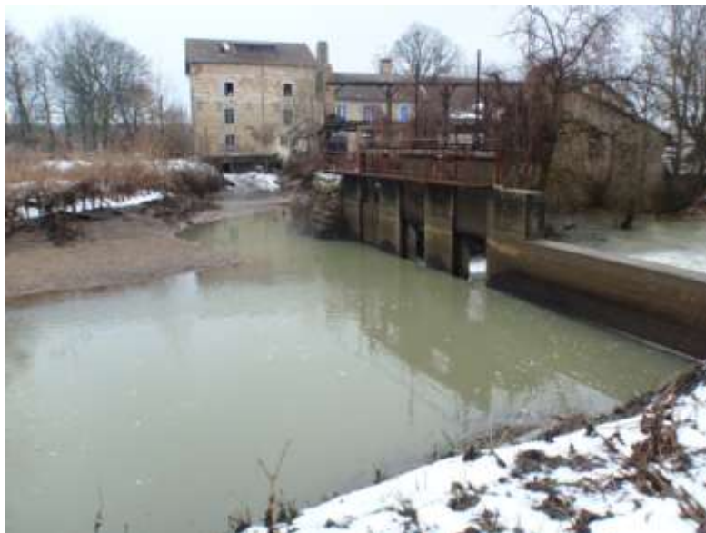
Figure 16 : Barrage avec vannes, du Moulin de Vaivre
