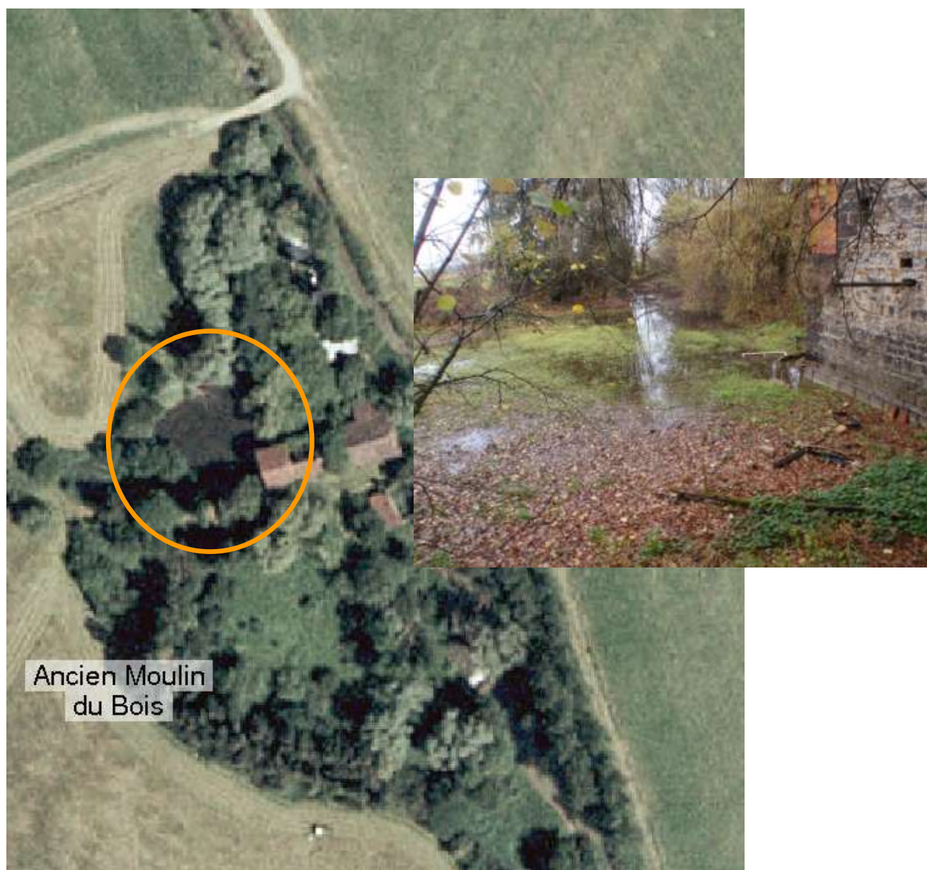
Figure 10 : Points de vue sur le canal de fuite de l'ancien moulin du bois
