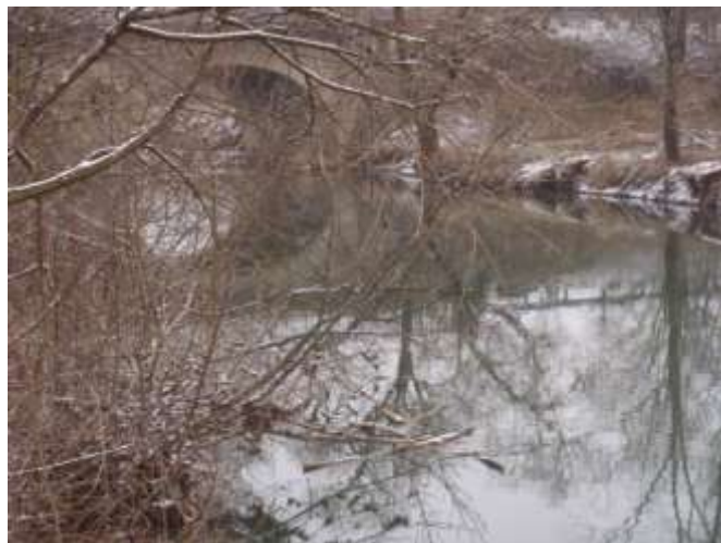
Niveau d'eau calé à l'aval par le radier du pont
