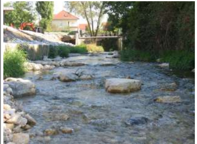
Figure 3 : Blocs de diversification sur le Gland (25) (AQUATIQUE SYSTEME)
