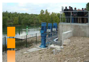
Vue des pompes
