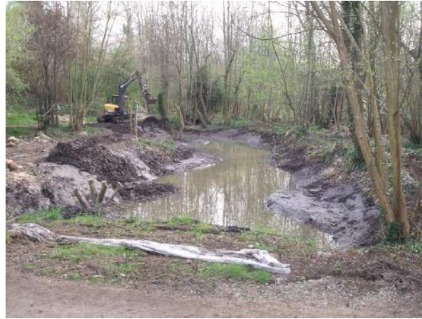
Pendant les travaux
