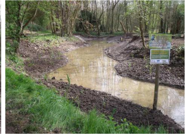
Pendant les travaux
