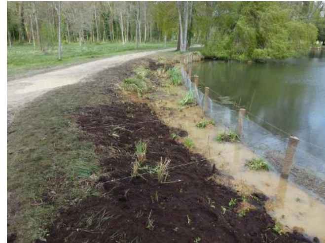
Fin des travaux
