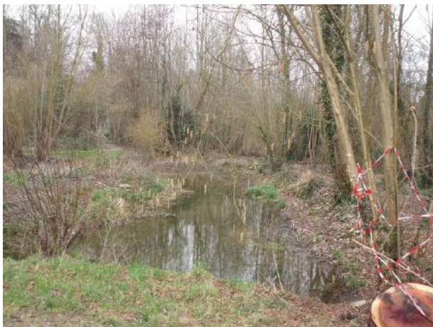
Fin des travaux
