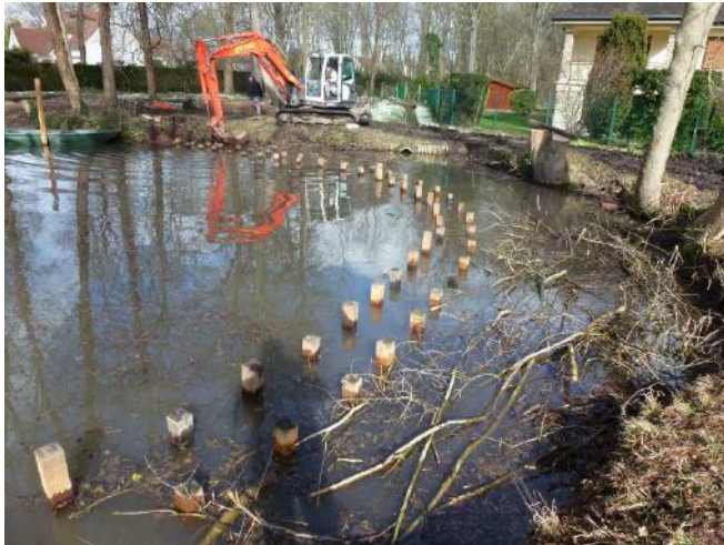
Pendant les travaux
