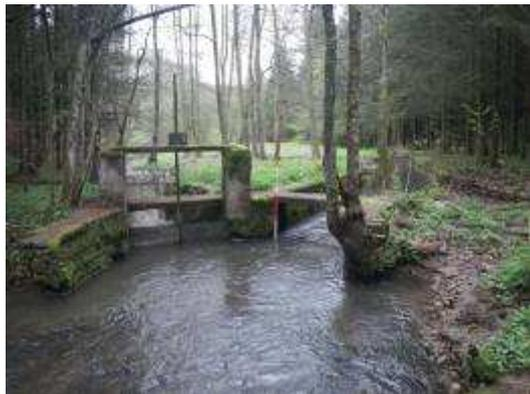
Seuil qui permet de diriger la plus grande partie des écoulements vers un canal d'alimentation du Canal des Vosges
