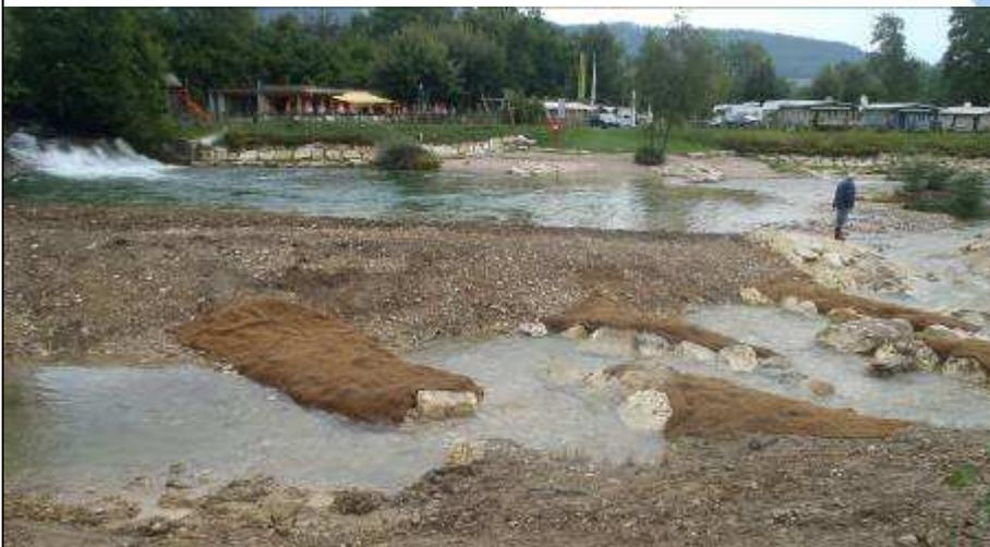
Exemple d'une rivière de contournement (photo Fluvial.IS)
