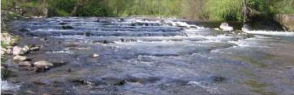
Photo. 1 : exemple de l'ouvrage de Kolbsheim sur la Bruche (67) : à gauche la rampe rugueuse franchissable, à droite l'ancien seuil toujours visible et infranchissable (Photo Fluvial.IS)
