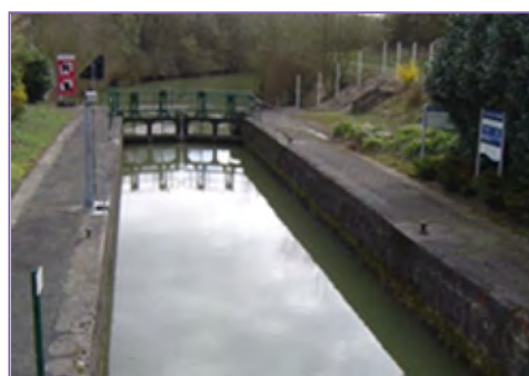
Le canal de la Somme Ecluse n°7 Sormont
