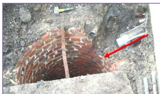
Rejet direct dans un puits d'infiltration sur le Vermandois
