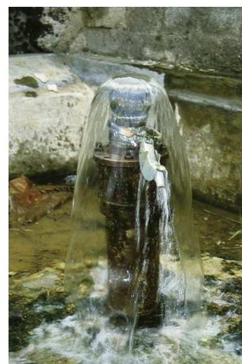
Figure 2 : Forage artésien captant la nappe astienne
