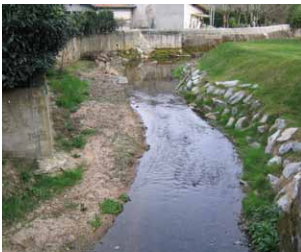
— Le Charbonnières dans le parc de la Bressonnière avant les travaux.
