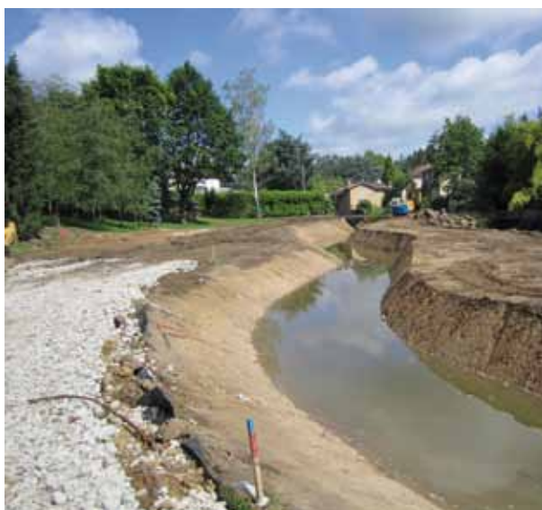
— Un lit provisoire de dérivation, préfigurant l'emplacement du futur cours d'eau déplacé dans le parc, a été aménagé.
