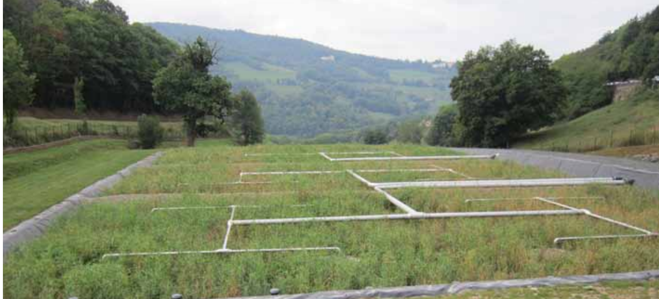
— La mise en service de la STEP d'Yzeron.
