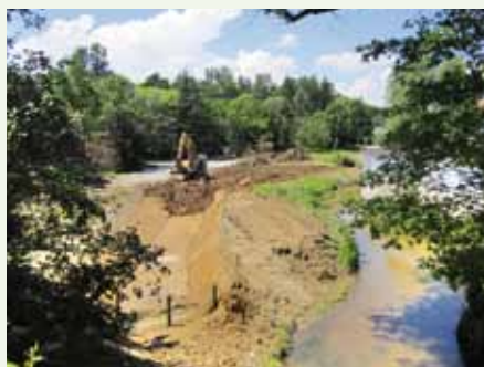
— Creusement du canal de dérivation provisoire juin 2012
