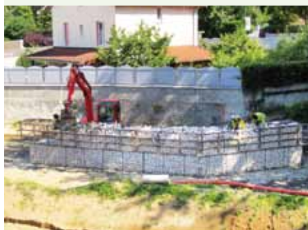
— Construction du mur de soutènement en gabions - juillet 2012
