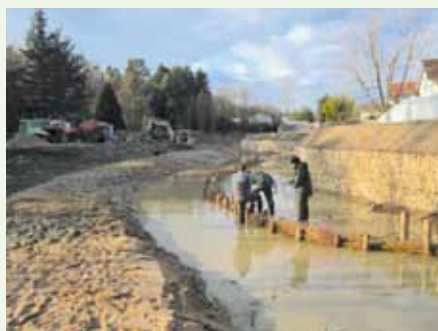
— Démarrage du lot génie végétal - pose de la fascine en pied de digue - novembre 2012
