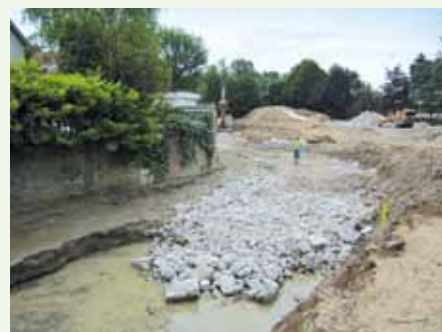
— Cloutage de la piste d'accès et de la fondation de la future digue de protection - juin 2012
