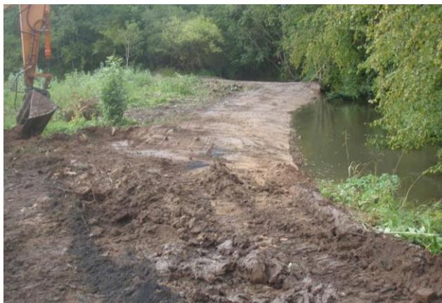
Photo 18 : Arasement du merlon et retalutage en pente douce
