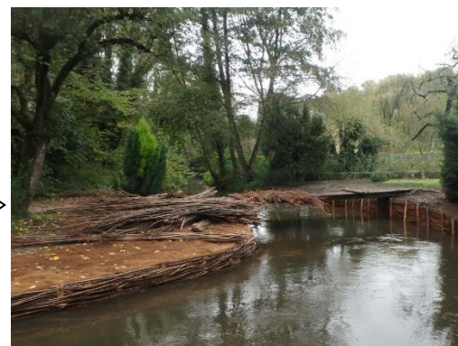
Photo 14: Tressage de saule (à gauche)
