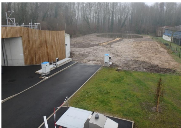
Photo 32 : Station d'épuration de Béthisy-Saint-Pierre et sa mare tampon avant le rejet dans l'Automne
