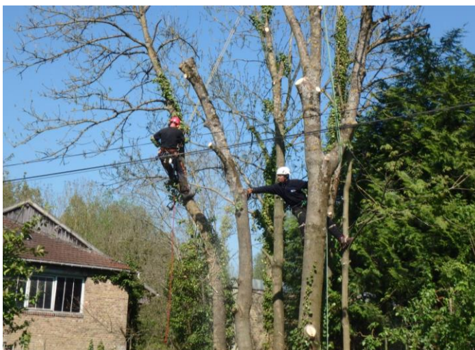
Photo 21 : Démontage en secteur urbain (Béthisy-Saint-Pierre)
