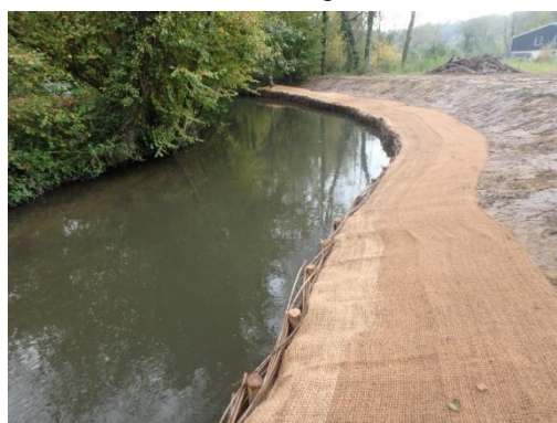
Photo 20: Tressage de saule et protection en géotextile
