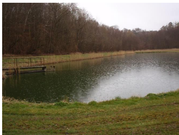
Photo 2: station d'épuration de Vauciennes
