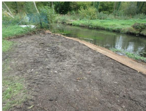
Photo 11 : Reprofilage de la berge en pente douce
