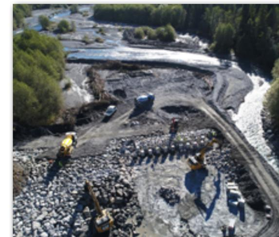
Sur le **Foron de Taninges**, quatre ouvrages fortement dégradés concourent à l'instabilité du lit et des ouvrages alentours (murs de protection et ponts). Ils constituent également un obstacle à la continuité écologique.
