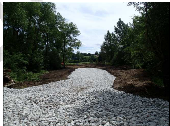
Travaux du CIC n°4 – préparation du cloutage de l'emprise du barrage (été 2015)
