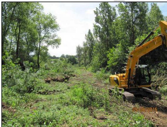
Travaux du CIC n°4 – déboisement (été 2015)
