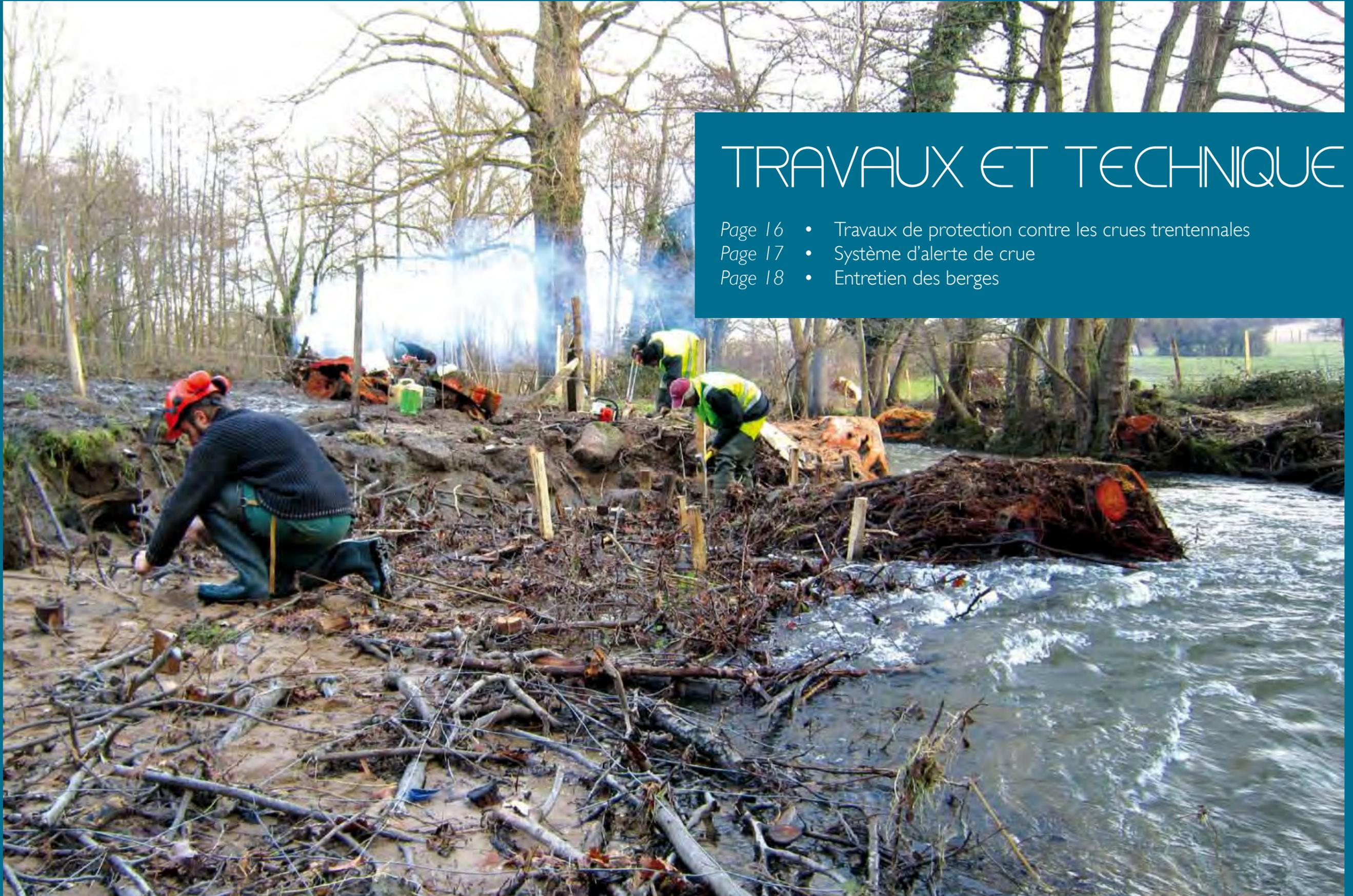
Mise en place d'une technique végétale pour le renfort d'une berge sur le Garon à Messimy.
