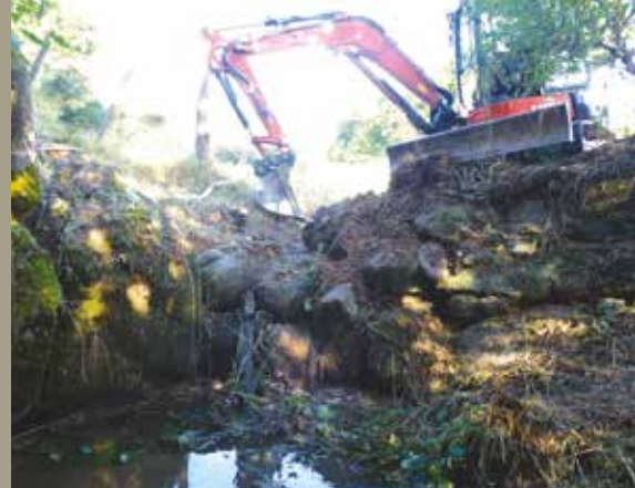
Rabaissement d'un seuil pour assurer la continuité piscicole sur le Cartelier à Rontalon au lieu-dit le Rieu. Ci-dessous, photo du site après l'aménagement.
