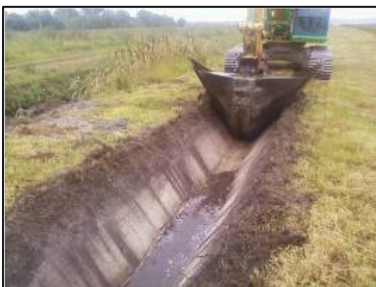
Création du nouveau fossé
