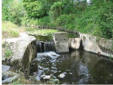
Figure 28 : Photo d'un barrage maçonné, barrage la Gourgoulière (Evre)
