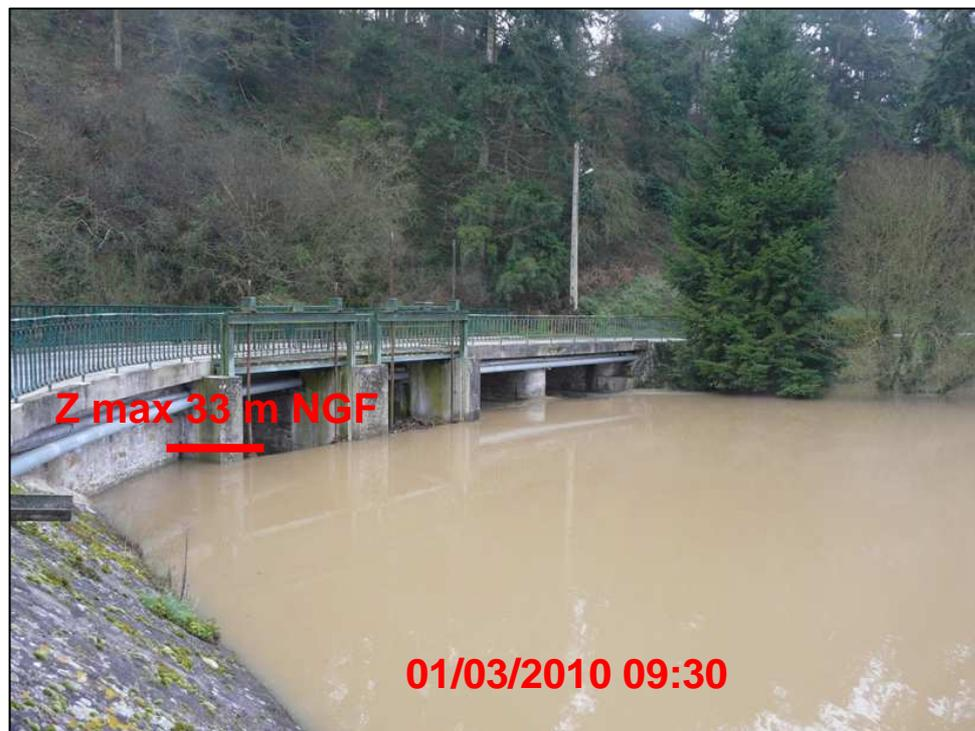
On note que pour la crue du 28 février 2010, la commune a abaissé les vannes à la décrue pour limiter les débits restitués (le 1<sup>er</sup> mars vers 12 :00), ce qui dans les faits a eu peu d'impact sur les débits restitués.
