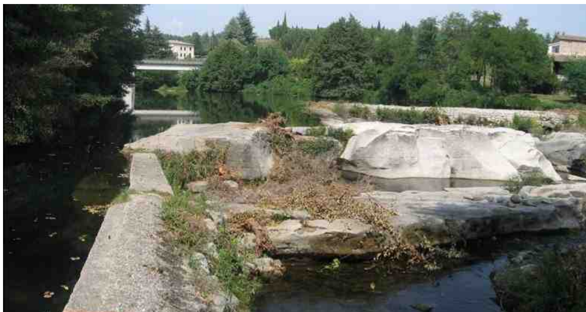
Figure 6 : Photo du canal d'Amenée et du Seuil (POYRY, 2012)
