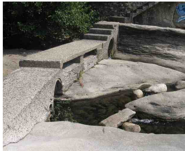
Figure 10 : Photo Escalier accès en rive gauche (POYRY, 2012)
