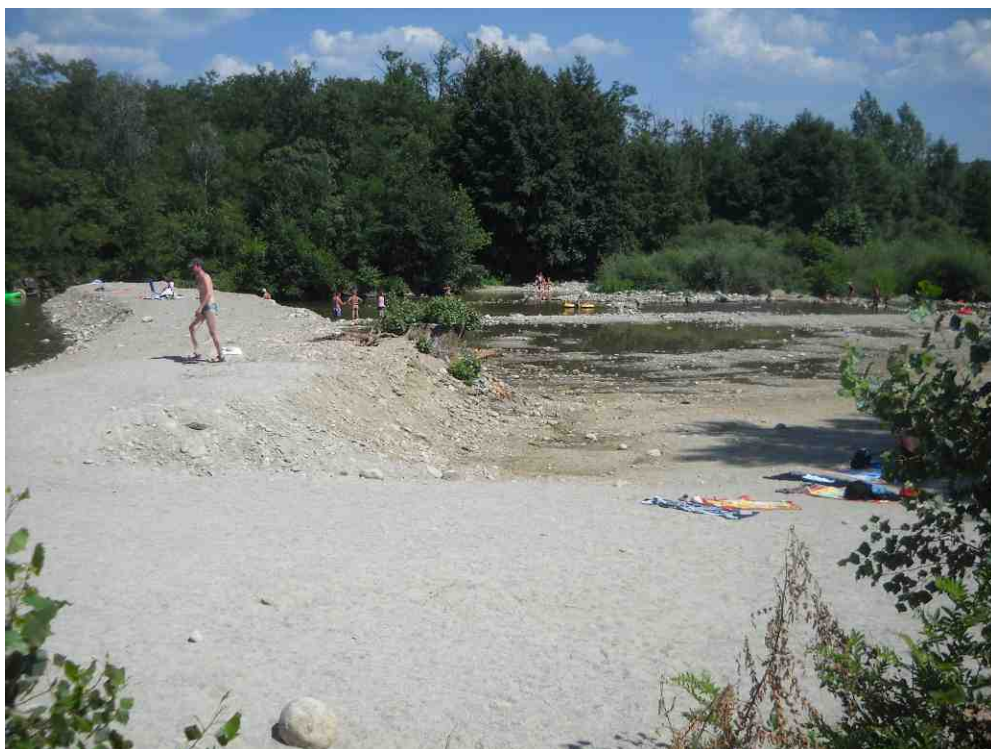
Figure 37 :Photo du seuil du Petit Rocher (POYRY, 2010)
