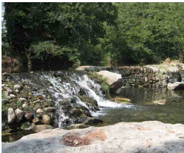
Figure 11 : Photo de galets constituant le seuil avec surverse et infiltration (POYRY, 2012)
