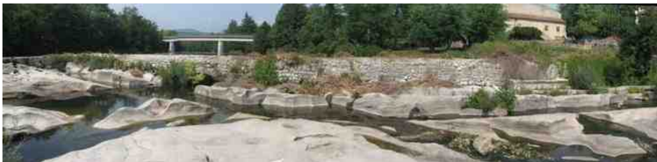
Figure 5 : Photo panoramique du seuil de Rosières depuis l'Aval (POYRY, 2012)
