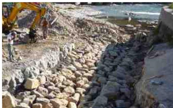
**Figure 11 : Exemple de chenal d'écoulement.**
