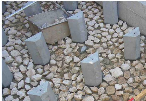
**Figure 10 : Exemple de macro-rugosité en éléments préfabriqués.**
