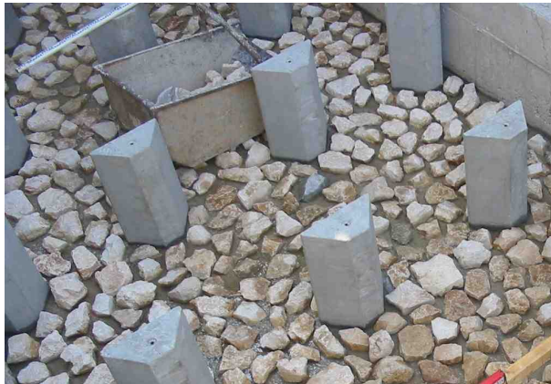
Figure 11 : Exemple de macro-rugosité en éléments préfabriqués.
