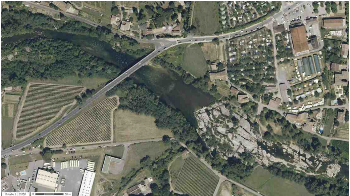
Figure 2 : Photographie aérienne du Seuil de Rosières et du Pont de la RD104a franchissant la Beaume (Géoportail, 2012)
