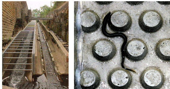
Photo 27 : Exemple de passes à anguilles avec substrat plots bétons. Source : M.I.G.A.D.O.
