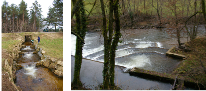
Photo 24 : Exemple de prébarrages. Source : M.I.G.A.DO.
