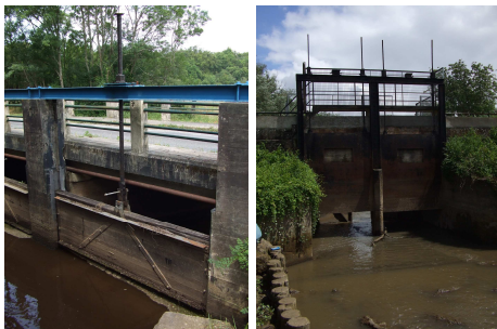
Photo 21 : Vannes en position ouverte. Source : M.I.G.A.DO.
