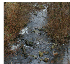
Photo 20 : Démantèlement d'un seuil.
