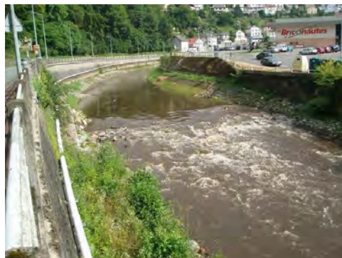
Ouvrage après travaux
