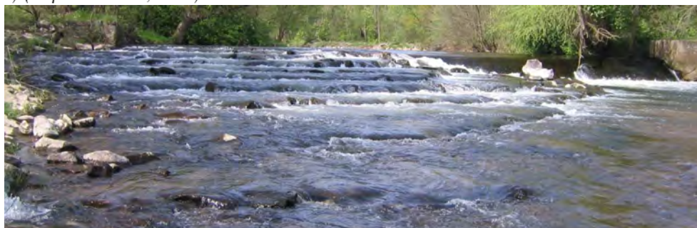
Photo. 1 : exemple de l'ouvrage de Kolbsheim sur la Bruche (67) : à gauche la rampe rugueuse franchissable, à droite l'ancien seuil toujours
