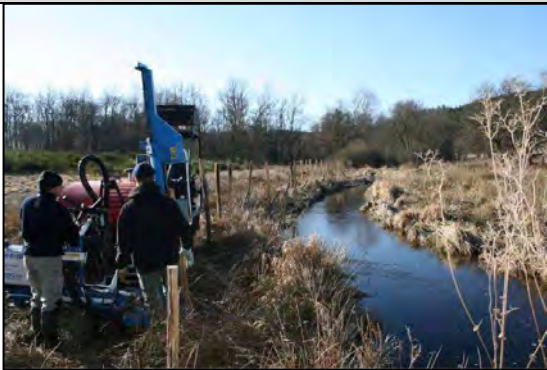
Implantation d'une clôture en bord de cours d'eau (Sources : LIFE 04NAT/FR/000082), in étude piscicole et astacicole des rivières du Mâconnais (oct.2010)
