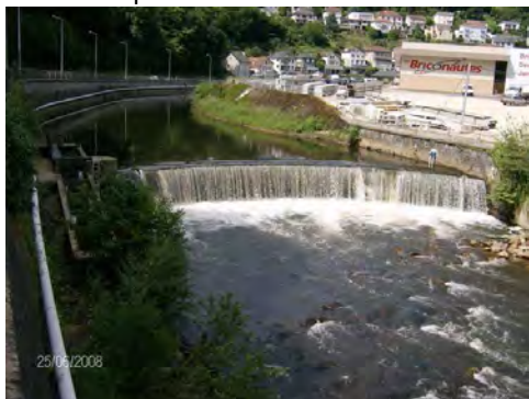
Ouvrage avant travaux
