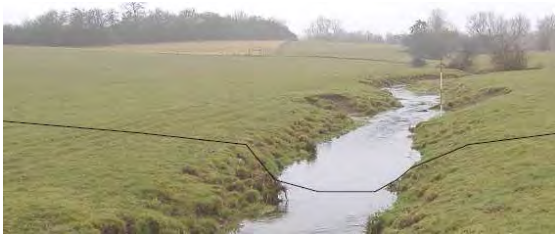
Figure 2 : un exemple de lit surcalibré à faible rugosité de tête de bassin (le Vair en tête de bassin, Contrexéville, 2008) : l'augmentation de la rugosité permet d'améliorer la fréquence de remplissage du lit majeur. L'objectif est l'inondation de zones à enjeu écologique au bénéfice de la réduction de l'inondabilité de zones aval à enjeux forts (urbaines par exemple)
