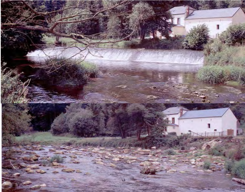
Photo. 2 : un exemple d'aménagement total en rampe rugueuse sans abaissement de la ligne d'eau : l'ouvrage de Boevange au Luxembourg (photo Adm. de l'Eau du Luxembourg)
